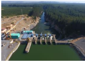
34 MW Laja Hydro
