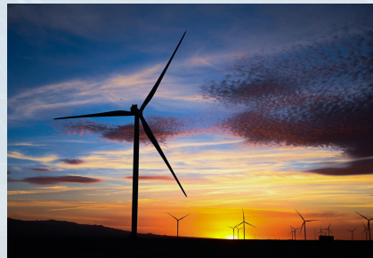
344MW Kallpa Wind (ex-Lomas de Taltal)
