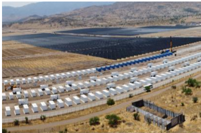
350MW* PV+BESS Libélula
