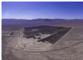
76MW / 418 MWh BESS Tamaya
