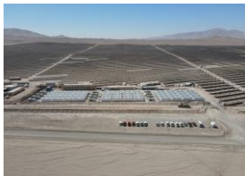
48MW / 264 MWh BESS Capricornio
